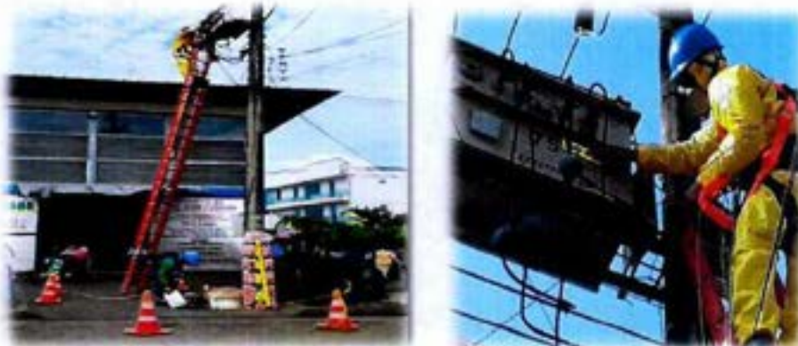
Ilustración 33. Toma de muestra - PCBs
