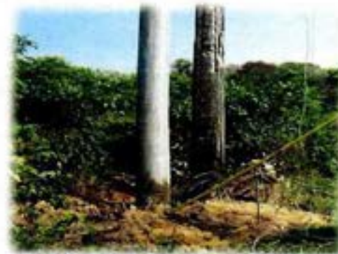
Ilustración 10. Reposición de postería en mal estado
