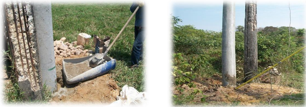
Ilustración 10. Reposición de postería en mal estado
