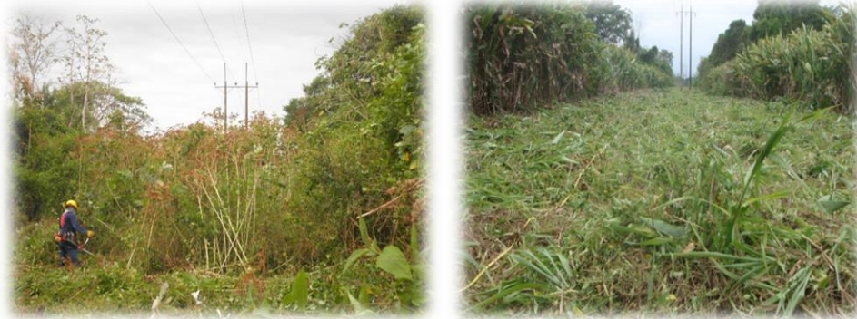
Ilustración 9. Limpieza de líneas de subtransmisión
