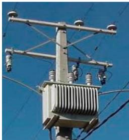
Es un dispositivo eléctrico que permite aumentar o disminuir la tensión en un circuito de corriente alterna, manteniendo la potencia eléctrica en la red de suministro.
